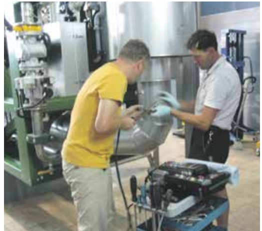
Laboringenieur der HS Ansbach Robert Herrmann (li.) und awean-Mitarbeiter Norbert May an einer Messstelle am BHKW. Foto: Yvonne Leinritz-Ponto
