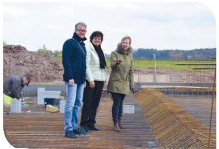
Auf der Baustelle in Feuchtwangen
