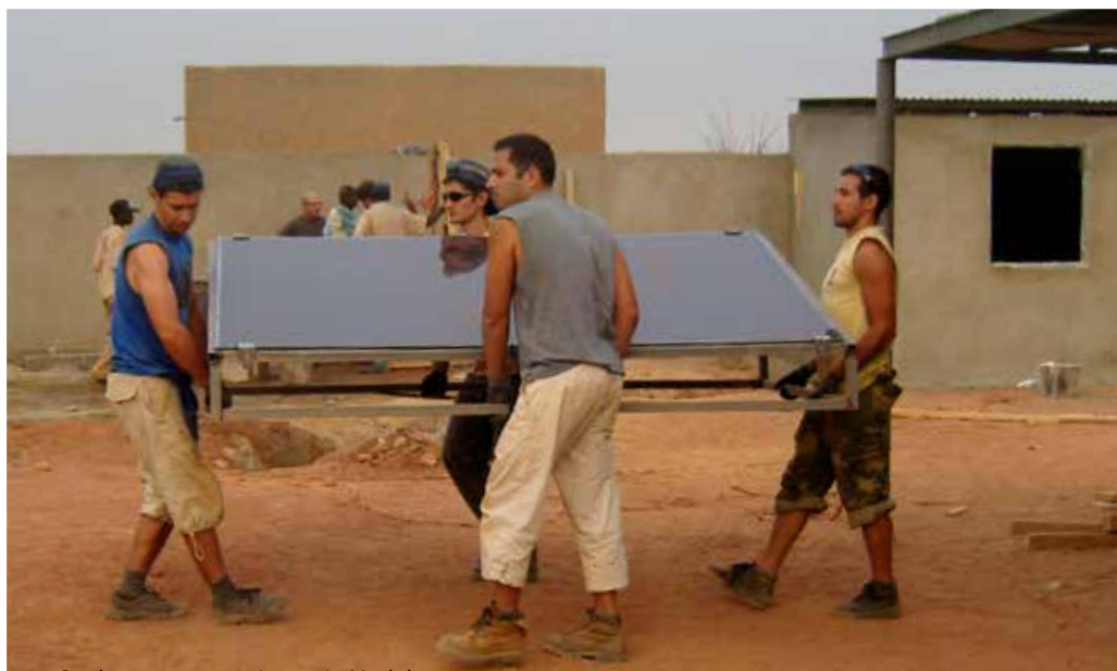
Studenten transportieren ein Modul für die Photovoltaik-Anlage
